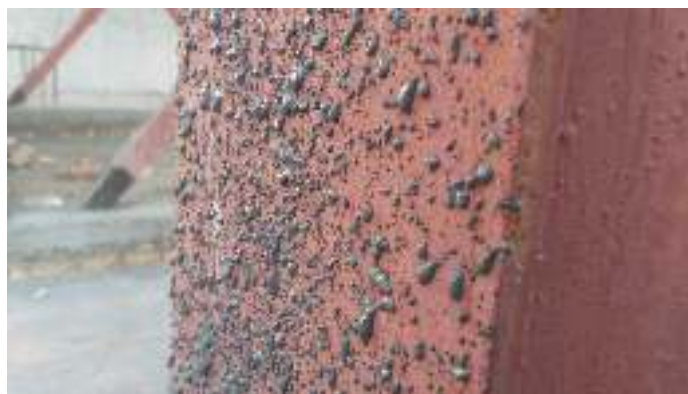
شکل ۲۰- پلیمر مضرس کننده بر روی ستون فولادی
