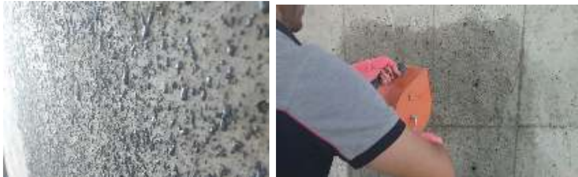
شکل ۱۹- اجرای پلیمر مضرس کننده بر روی دیوار برشی بتنی
