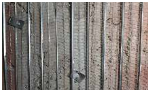
شکل ۴- اتصال رابیتس به سطح زیر کار
