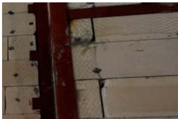
شکل ۳- استفاده از توری مرغی و اتصال آن به سطح زیرکار (بلوک)
