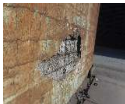
شکل ۴ - نمونه های از خوردگی‌های بتن
