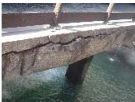
شکل ۴ - نمونه های از خوردگی‌های بتن
