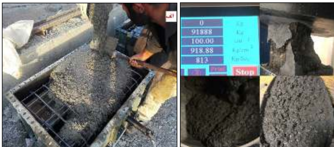
شکل ۷- شکل سمت راست نمایی از طرح مخلوط بتن اصلاح شده در آزمایشگاه و نتیجه مقاومت فشاری ۵۶ روزه آن ، شکل سمت چپ اجرای این بتن در قطعه پیش ساخته با اسلامپ ۲۰ سانتیمتر بدون جداسدگی
