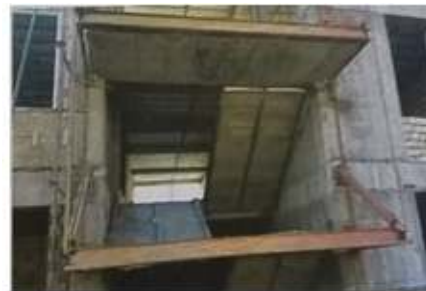
شکل (۲۲) - اجرای راه پله فولادی در اسکلت بتنی
