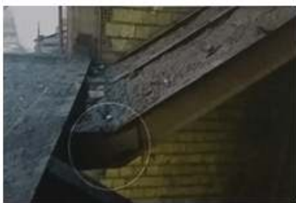
شکل (۲۳) - استفاده از ورق در محل اتصال
