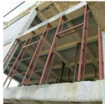
شکل (۱۴)- نمونه اجرایی صحیح از وال پست‌ها
