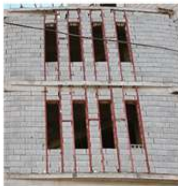
شکل (۱۴)- نمونه اجرایی صحیح از وال پست‌ها
