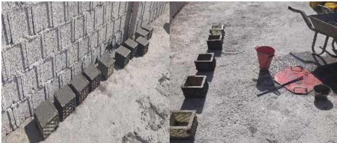
شکل ۸. مراحل ساخت و قالب های استفاده شده
