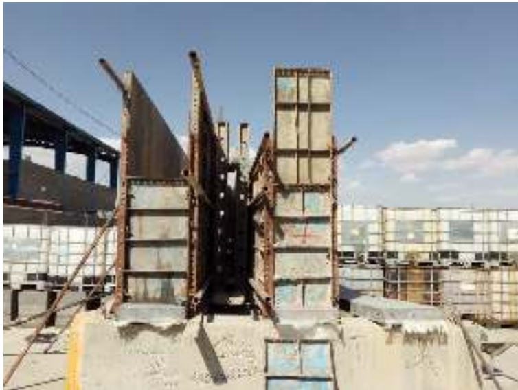
شکل ۵- قالب بندی دال با ۲ و ۳ لایه ورق GFRP
