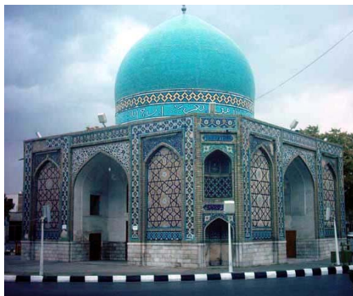
شکل ۱- نمایی از بنای گنبد سبز
