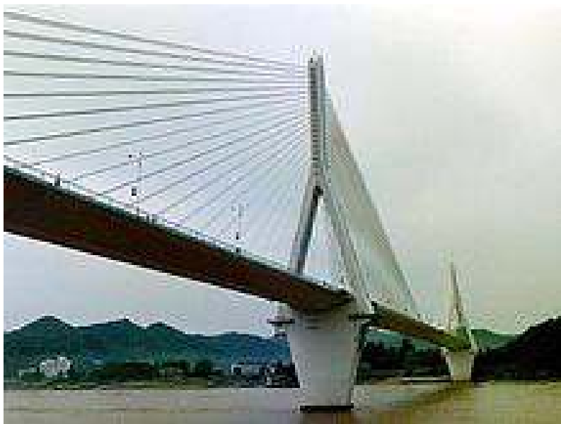
شکل ۱- پل کابلی سازه پیش‌تنیده بر روی رود یانگ‌تسه [۴]
