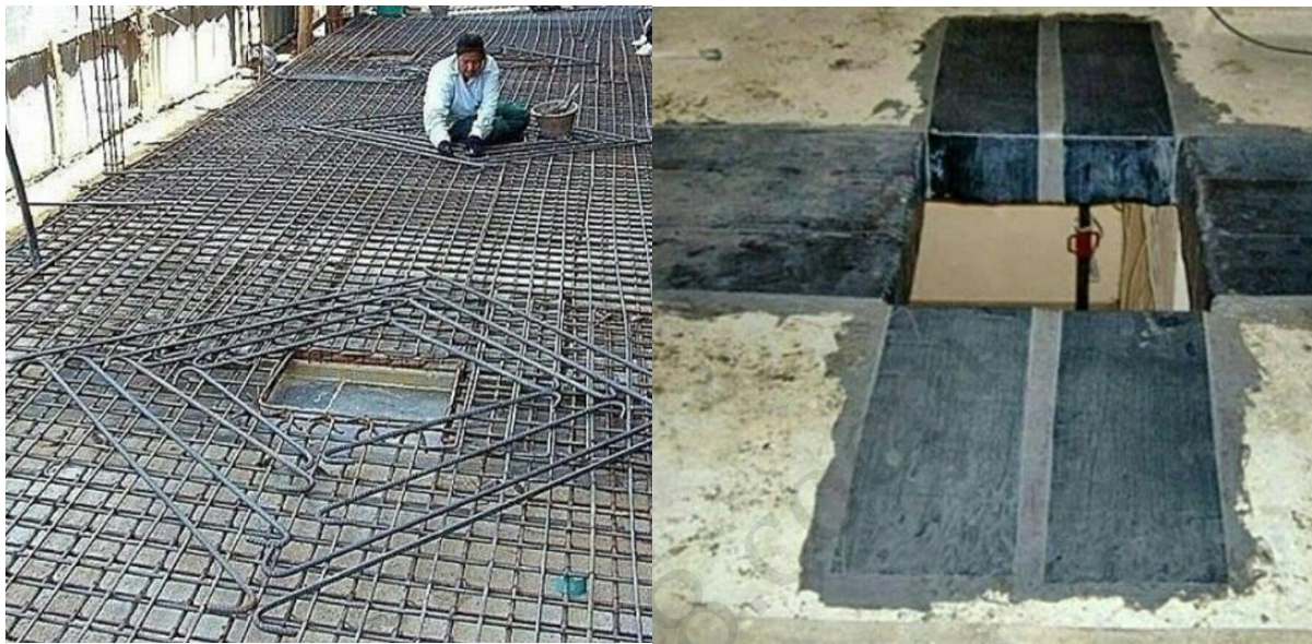
13 کاور در چشمه اتصال رعایت نشده
