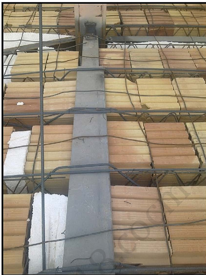
شکل ۴-۷۳ (آرما تور اوتکا دو طرفه در سازه های فلزی)
