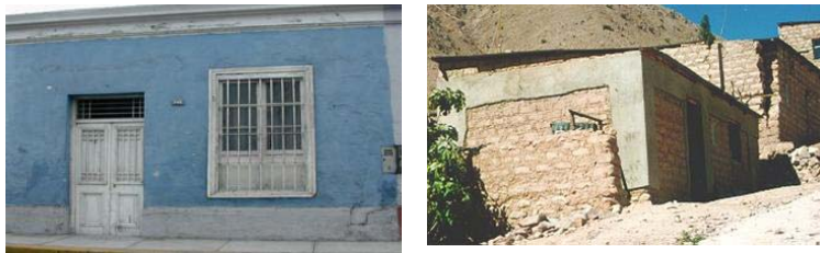
ساختمانهای خشتی تقویت شده در پرو که در هنگام زلزله خسارتی ندیدند
