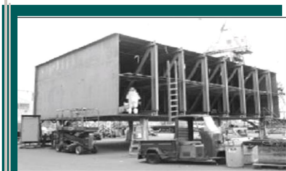
تصویر دیجیتال از یک سازه در حال ساخت
