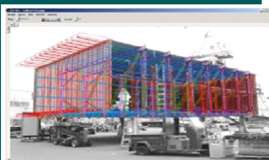
با تطبیق مدل CAD و تصاویر دیجیتال از سازه در حال ساخت نشان می دهد که پانل متصل کننده فوقانی هنوز نصب نشده است.
