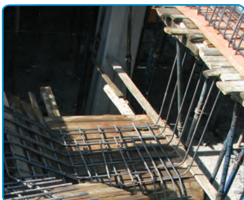
شکل ۴۱-۷- اجرای میلگردهای دال پله
