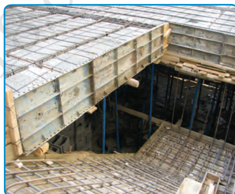
شکل ۴۰-۷- اجرای میلگردهای دال پله
