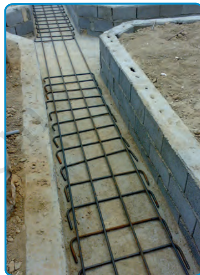
شکل ۸-۷- چیدن میلگردهای طولی و عرضی
