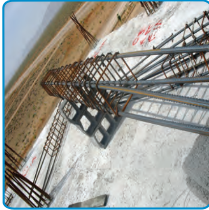
شکل ۷-۲۲- آماده کردن میلگردهای تیر روی زمین
