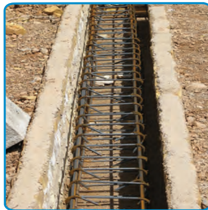
شکل ۵-۷- اجرای میلگرد شناژها
