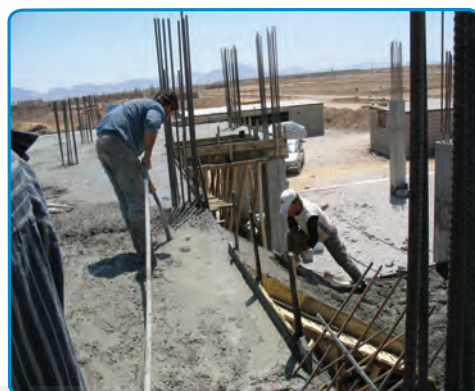
شکل ۴۲-۷- بتن ریزی دال پله
