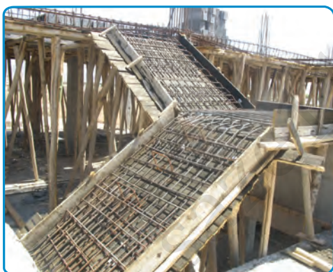
شکل ۳۹-۷- اجرای میلگردهای دال پله
