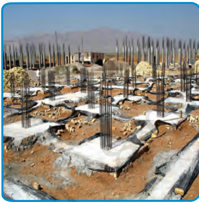
شکل ۱۷-۷- اجرای خاموت و سنجاقک
