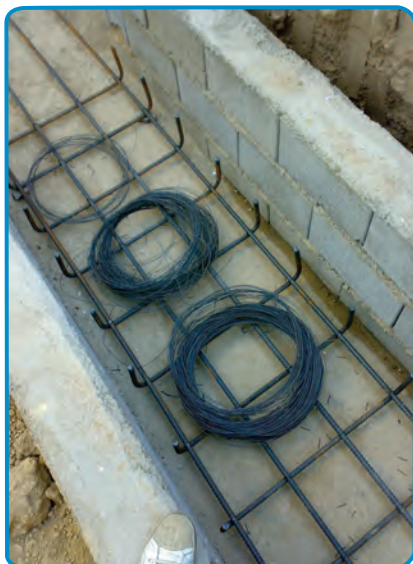
شکل ۹-۷- بهم بستن میلگردها
