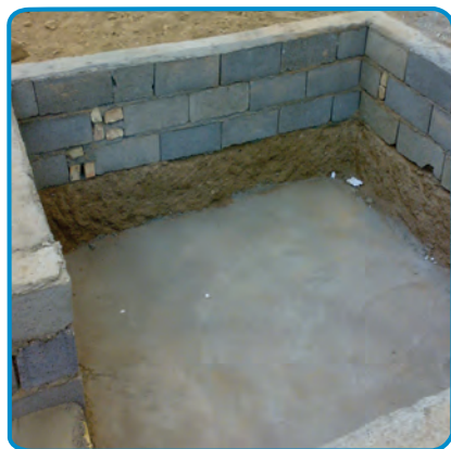
شکل ۱-۷- آماده سازی کف پی
