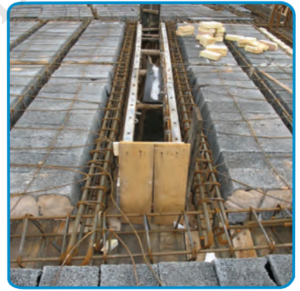
شکل ۷-۳۰- اجرای بازشودر سقف
