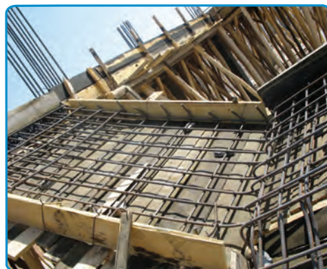
شکل ۳۸-۷- اجرای میلگردهای دال پله
