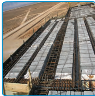
شکل ۷-۳۳- اجرای کنسول ها
