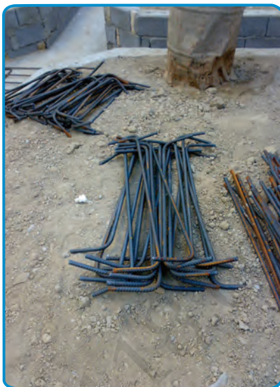
شکل ۷-۷- آماده کردن میلگردهای طولی و عرضی
