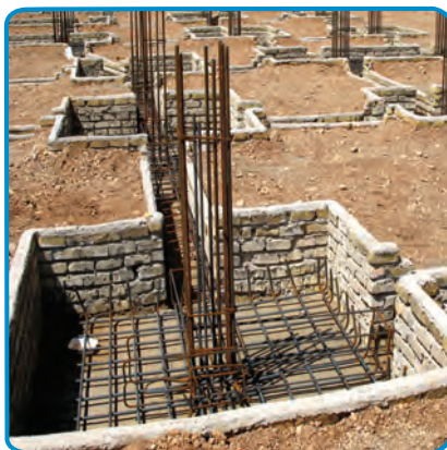
شکل ۴-۷- اجرای میلگردهای ریشه انتظار
