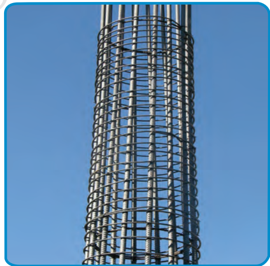
شکل ۲۰-۷- میلگرد گذاری مارپیچ در ستون
