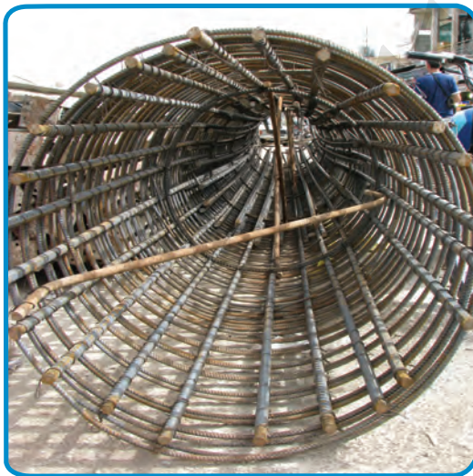
شکل ۲۰-۷- میلگرد گذاری مارپیچ در ستون
