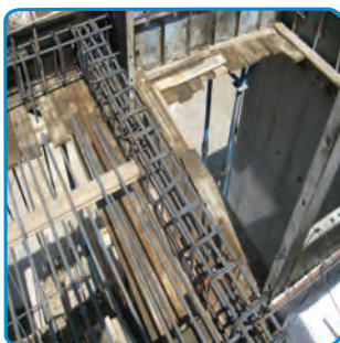
شکل ۷-۳۱- اجرای بازشودر سقف
