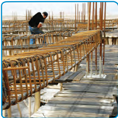
شکل ۷-۲۴- تنظیم فاصله بین خاموت ها
