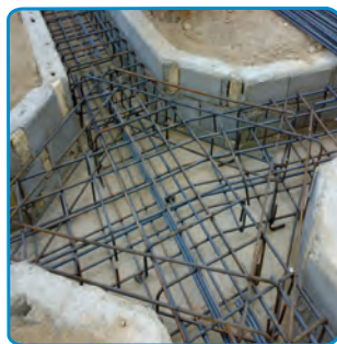
شکل ۱۴-۷ تکمیل میلگردگذاری محل اتصال ستون
