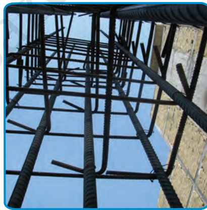
شکل ۱۹-۷- کار گذاشتن میلگردهای انتظار ستون، در فونداسیون
