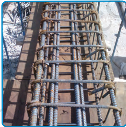
شکل ۷-۲۵- بستن خاموت ها با مفتول
