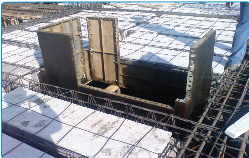
شکل ۳۵-۷- تکمیل قالب بندی
