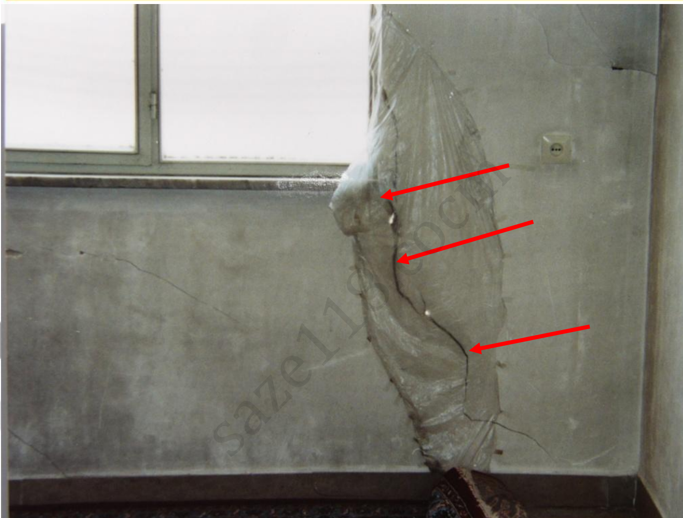
تصویر شماره 7 - ترك ایجاد شده در دیوار ، بعلت نشست دیوار در قسمت چپ عکس
