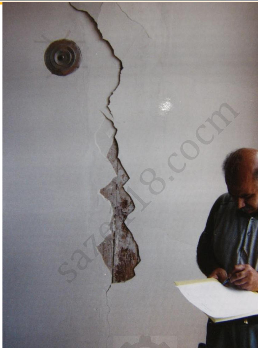
تصویر شماره 9 - ترك های ناشی از انقباض و انقباض ستون فلزی ساختمان
