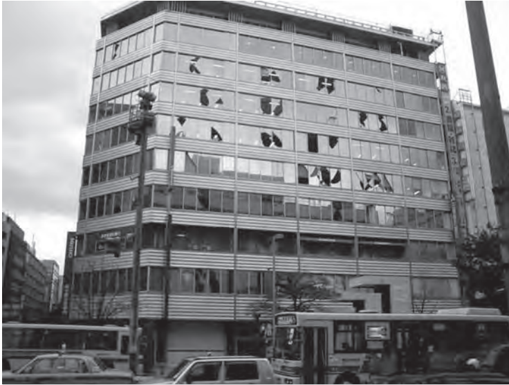
نمونه‌ای از خسارات وارد شده به شیشه‌های نما در زلزله ۲۰۰۵ فوکوکا
