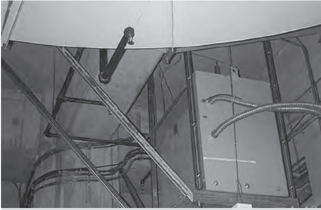
نمونه‌ای از بخاری‌های سقفی مهار شده
