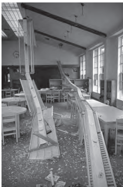
نمونه خسارات وارد شده به چراغ‌های ثابت در زلزله
