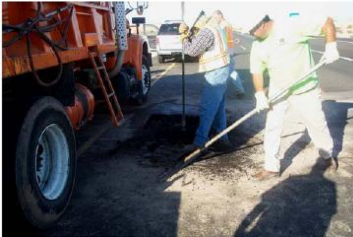
شکل ۳-۱- روش ریختن و غلتک زدن
