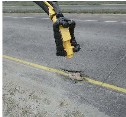
شکل ۳-۳- تمیز نمودن چاله جهت ترمیم
