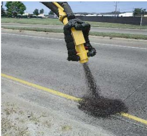
شکل ۳-۴- تزریق با فشار مخلوط قیر و سنگدانه
