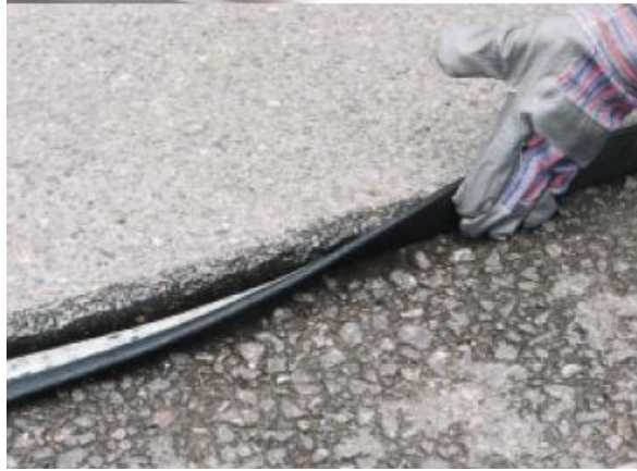
نصب نوار لکه‌گیری بر روی دیواره آسفالت
