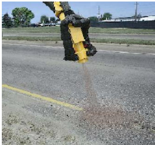
شکل ۳-۵- کاربرد پوششی از سنگدانه خشک
