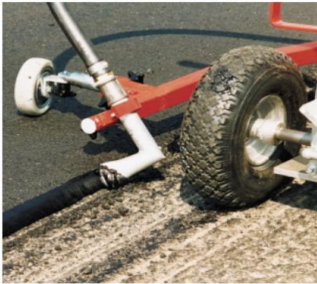
اندود سطح دیواره آسفالت موجود با مواد چسبنده با دستگاه مخصوص
