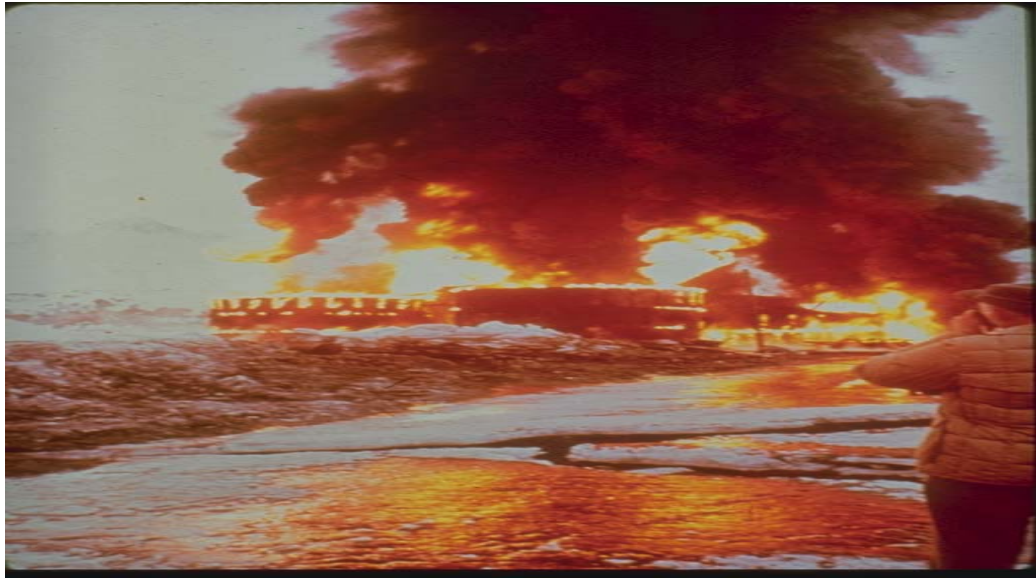
آتش سوزی پس از وقوع روانگرایی و قطع خطوط انتقال آب
