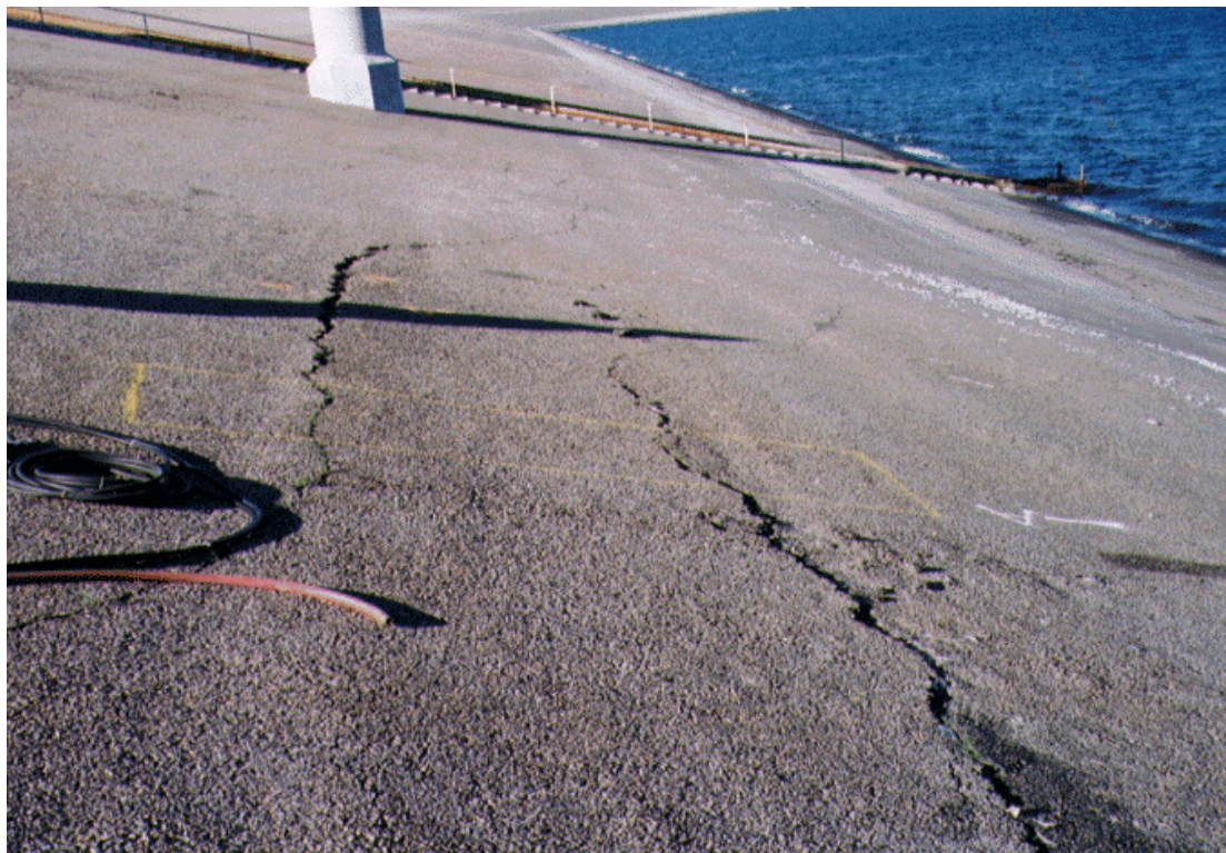
ترک در بالادست سد Los Angles در زلزله Northridge (۱۹۹۴)
