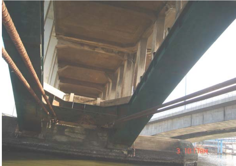
تصویر زیر اتصال تیر ورق به کلاهیک شمع را نشان می دهد
