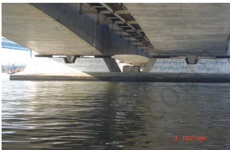
جانمایی نادرست تکیه گاه نئوپرن در پایه ها
