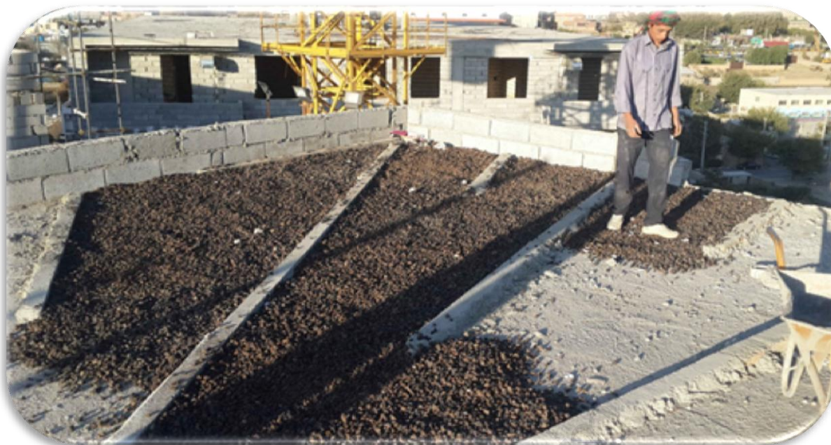
پر کردن فضای بین کرم ها با پوکه معدنی
