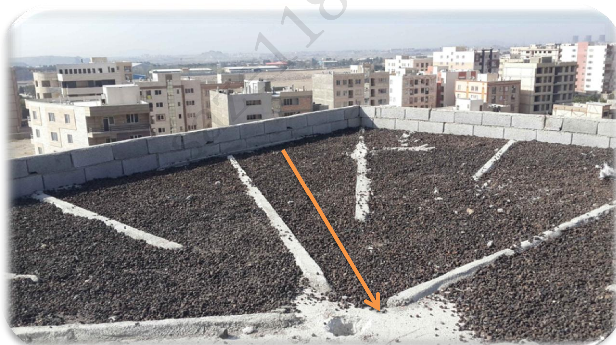
پر کردن فضای بین کرم ها با پوکه معدنی
