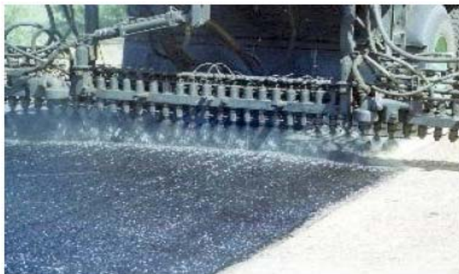
شکل شماره ۲-۲۰-۹- لوله پخش (spray bar)
