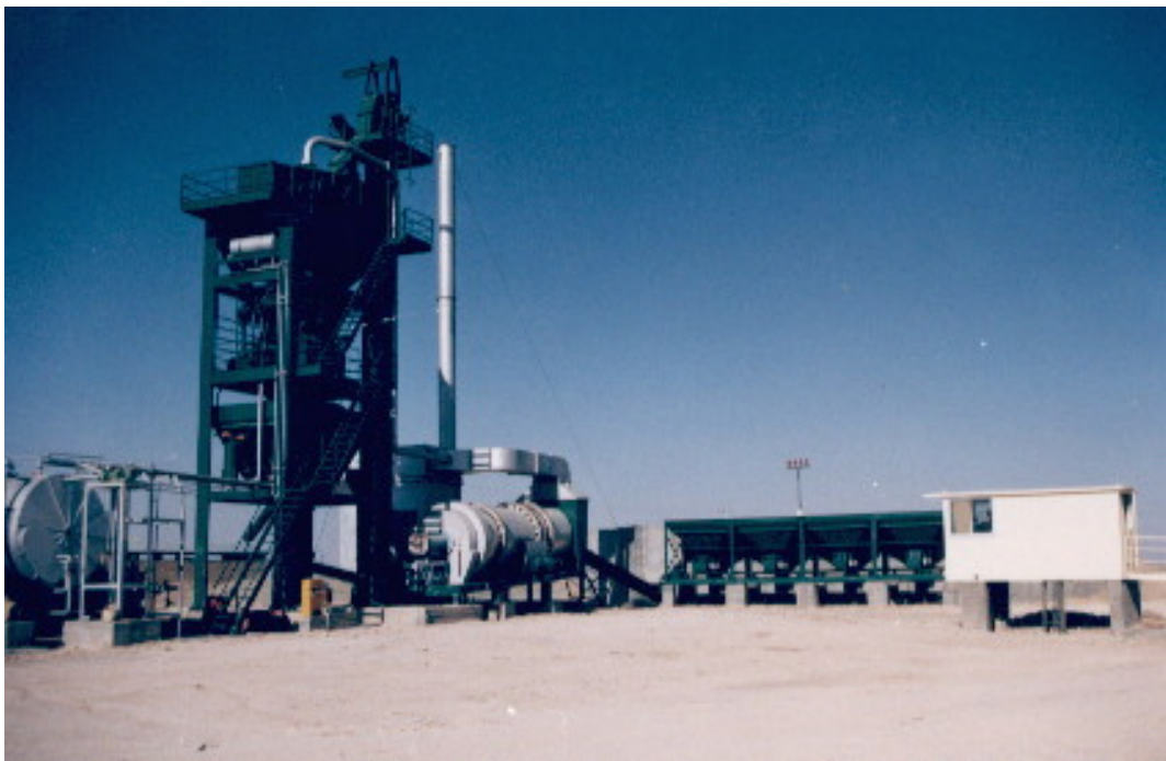
شکل شماره ۲-۲۱-۱- کارخانه آسفالت
