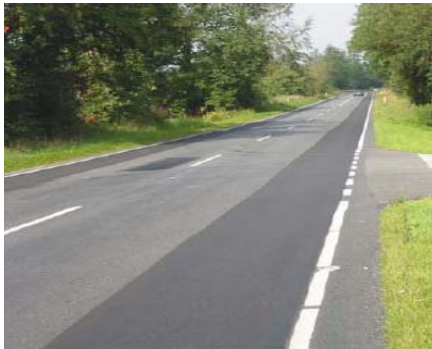
شکل شماره ۲-۲۰-۳- لکه گیری جاده ها
