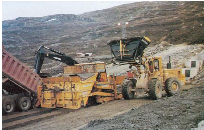
شکل ۲-۱۷-۴- بارگیری ماشین پخش مصالح سد هسته آسفالتی
