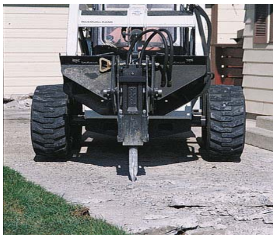
شکل ۲-۱۵-۳- چکش هیدرولیکی متصل به باب‌کت
