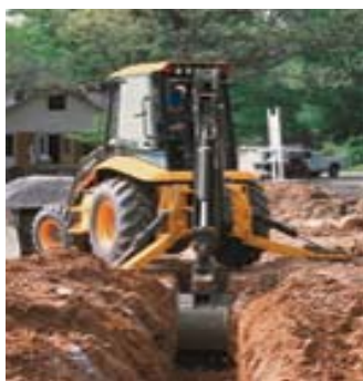
شکل شماره ۹-۲-۲- حفر کانال توسط بکهولودر
