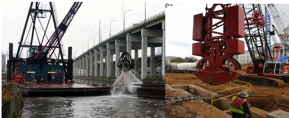
شکل (الف-۸-۱۲) کلامشل در حال عملیات در خاک شکل (ب-۸-۱۲) کلامشل در حال عملیات لایروبی
