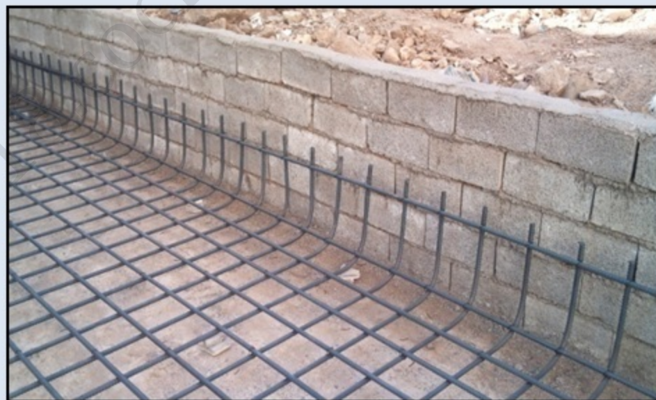
آرماتورهای تحتانی فونداسیون
