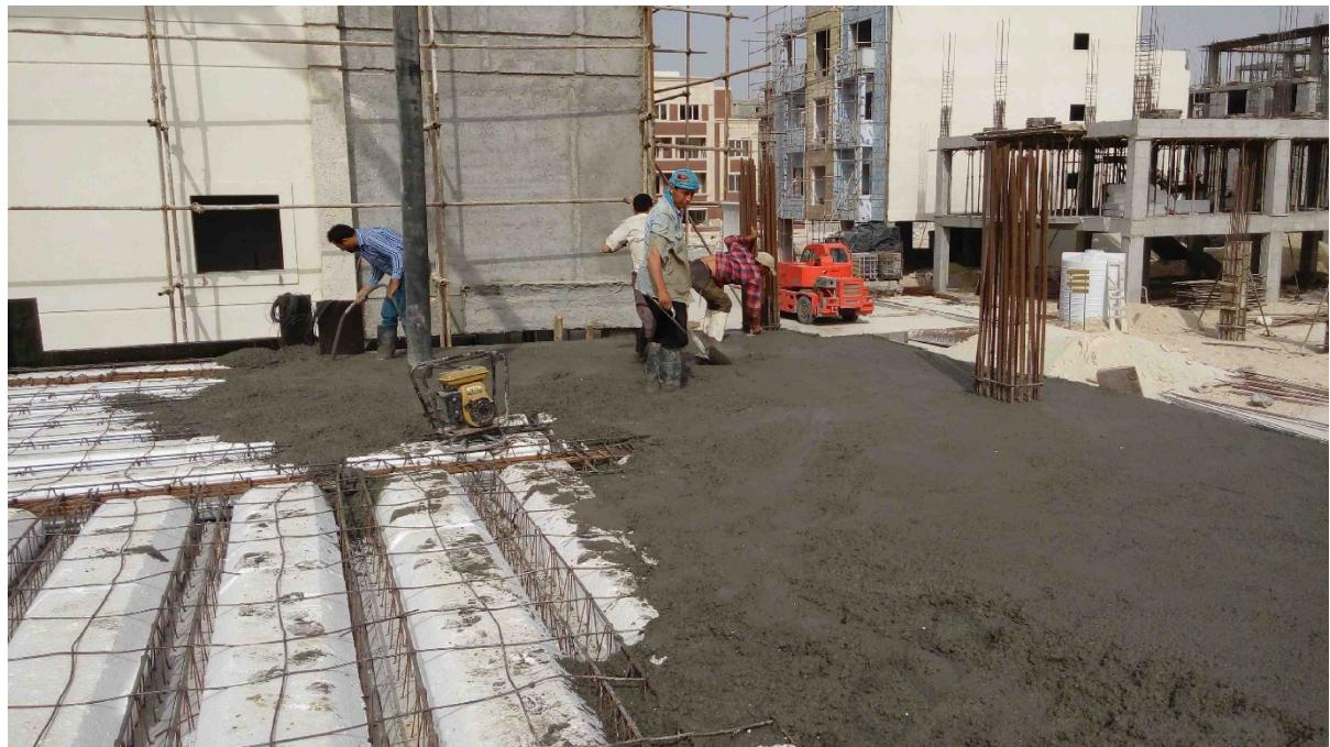
بعد از خشک شدن بتن ریزی و قالب برداری . اجرای پله و سقف و تیر و تیرچه و بلوک گذاری از نظر روش یکی می باشند برای طبقات تنها تفاوت این است که مقدار و قطر میلگرد و بتن ریزی طبق محاسبات تغییر می کند .
