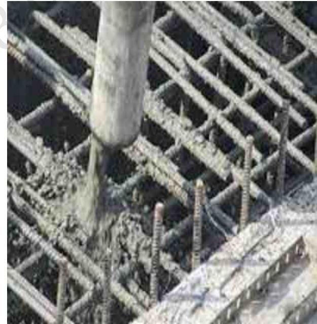
بعد از بتن ریزی بعد از 5 الی 6 ساعت می توان برای آب دادن اقدام کرد ، لازم به ذکر است که اگر به بتن آب داده نشد به اصطلاح باعث سوختن می شود .
