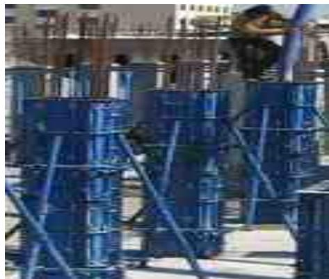
بتن ریزی ستونها که بعد از بستن قالب ها و شاقول کردن که در عکسها مشخص شده است . بتن بصورت آماده توسط میکسر ها آورده می شود و توسط پمپ دکل دار شوت می شود .
