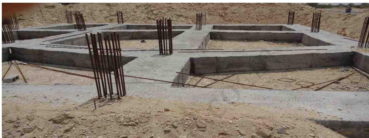
بعد از قالب برداری پی نوبت به آرماتور بندی ستونها می رسد که طبق نقشه صورت می گیرد .
