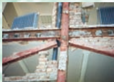
عدم اتصال صفحه مهاربند به گره تقاطع تیر و ستون
