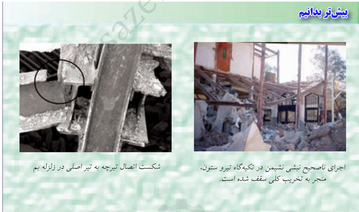
شکل ۸-۱۴- نمونه‌ای از اتصال نیمه صلب تیر به ستون
