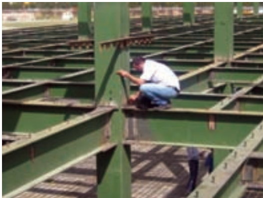
اتصال اعضای قاب در اسکلت فولادی
