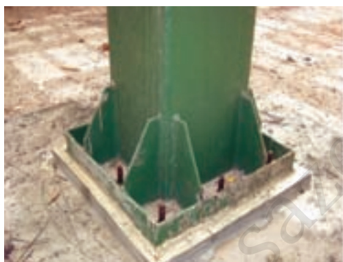
شکل ۸-۲۱- نمونه‌ی اتصال گیردار پای ستون با ورق سفت‌کننده
