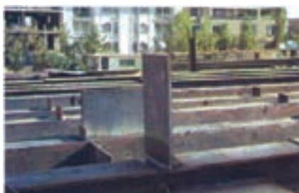
نصب ورق زیرسری روی ستون در کارگاه
