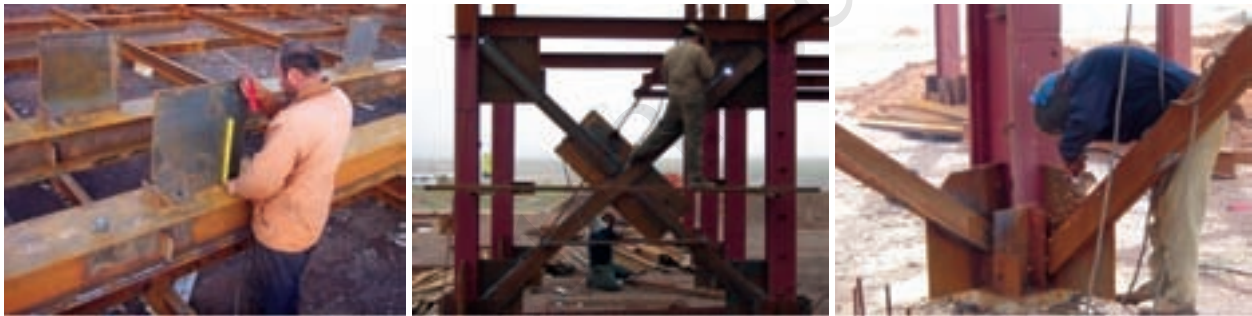
شکل ۸-۱۷- نمونه‌ی اجرای اتصالات مهاربندی
