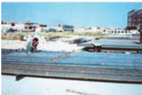
جوشکاری نبشی نشیمن روی زمین
