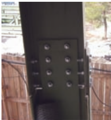
شکل ۸-۲۵- اتصال ستون به ستون بصورت پیچ و مهره‌ای
