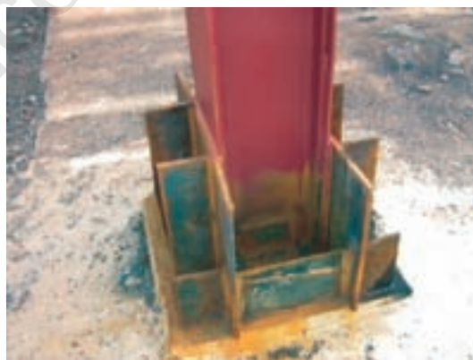
شکل ۸-۲۱- نمونه‌ی اتصال گیردار پای ستون با ورق سفت‌کننده
