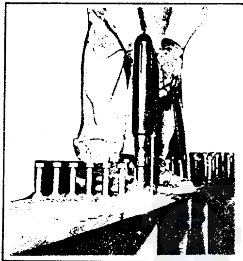
شکل ۶ - جوشکاری گلمیخ.
