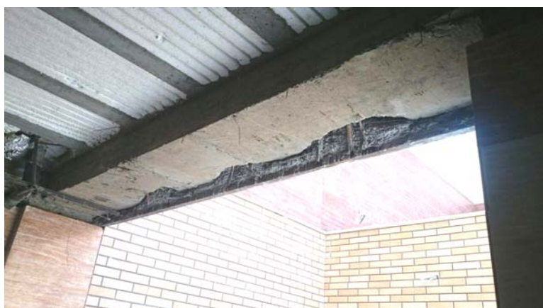
شکل ۸- اجرای نیشی کشی جهت اجرای سازه نگهدارنده نما و عدم توجه به آن در مرحله اسکلت و سقف که موجب تخریب پوتر شده است
