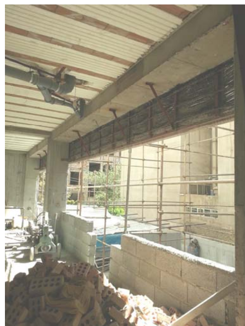
شکل ۸- اجرای نیشی کشی جهت اجرای سازه نگهدارنده نما و عدم توجه به آن در مرحله اسکلت و سقف که موجب تخریب پوتر شده است
