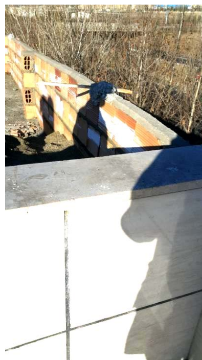
شکل ۱۳ - سمت راست: کوتاه بودن ارتفاع جانپناه بام و عدم اجرای صحیح سنگ در پوش و سمت چپ: اجرای صحیح پشت بندی ها و درپوش جانپناه بام
