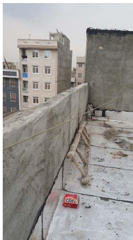
شکل ۲۱- عدم اجرای درپوش جانپناه بام و عدم اجرای قرنیز کف پنجره
