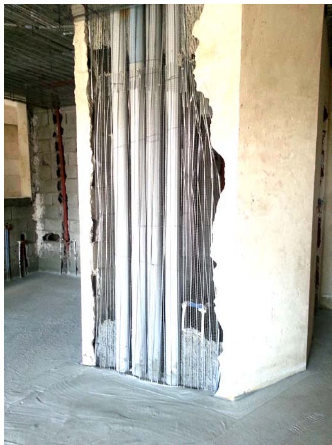
شکل ۱۱- تخریب دیوارها جهت عبور لوله های تاسیساتی
