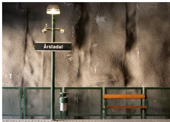
دیوارهای بتن پاشیده در تونلی که ایستگاه آرستادال در متروی استکهلم در آن واقع شده است.
