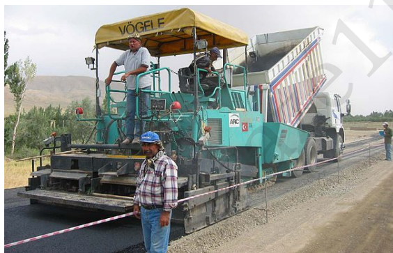
ماشین در حال فرش کردن بتن آسفالتی
