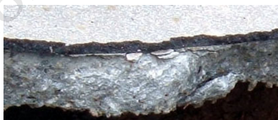
برش از بتن آسفالتی
