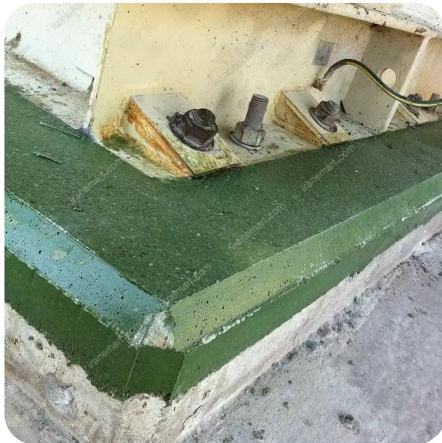
گروت اپوکسی Grout Epoxy ( مگاکریت ای پی ۳۳ ) یک گروت اپوکسی سه جزئی بدون حلال بر پایه رزین اپوکسی و هاردنر بسیار قوی بوده و برای محدوده وسیعی از کارهای ساختمانی و فونداسیون دستگاه های صنعتی که نیاز به تحمل بارهای استاتیکی و خصوصاً دینامیکی داشته یا درمعرض لزرش و ارتعاش می باشند طراحی شده است. این محصول علاوه بر کسب مقاومت های فشاری و خمشی بالا ، بدون انقباض بوده و دارای خاصیت روانی بالا و زمان کارپذیری مناسب می باشد.
