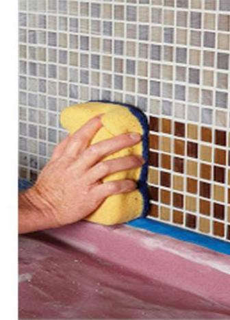
**میزان مصرف** کافیست جزء مایع را به پودر اضافه کرده. ملات حاصله جهت پر کردن درزها قابل استفاده است
